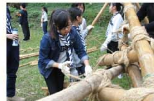
成員努力進行先鋒工程
